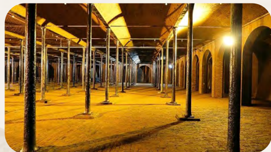
位於英國利物浦的Toxteths配水庫於1850年建成，該配水庫利用生鐵柱作支撐，這被認為是較具經濟效益的做法。
