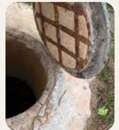
用以承托圓燈蓋的英泥沙批盪，狀態相當良好
