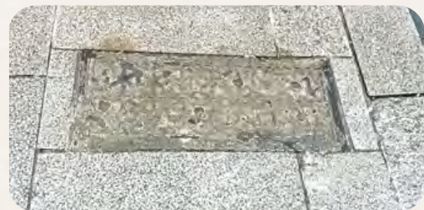
威靈頓街地下公廁的採光天窗遺跡，同為Luxfer出品（傅巧君小姐供圖）
